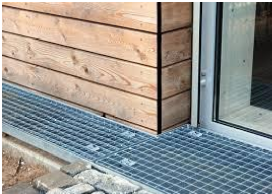
Abbildung 9: Beispiel einer Ausführung von Gitterrosten bei Holzfassade
