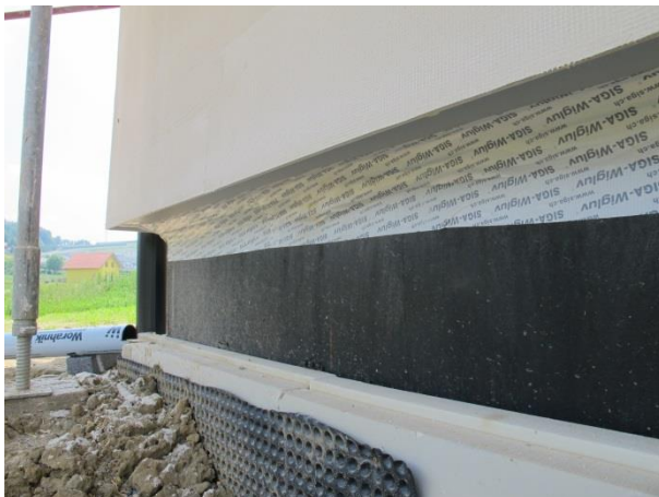
Abbildung 3: Fugenverschluss Außenwand/ Kellerdecke mittels Klebeband ( S_w \geq 150 mm) vor Montage der Sockeldämmung (Passestück)
