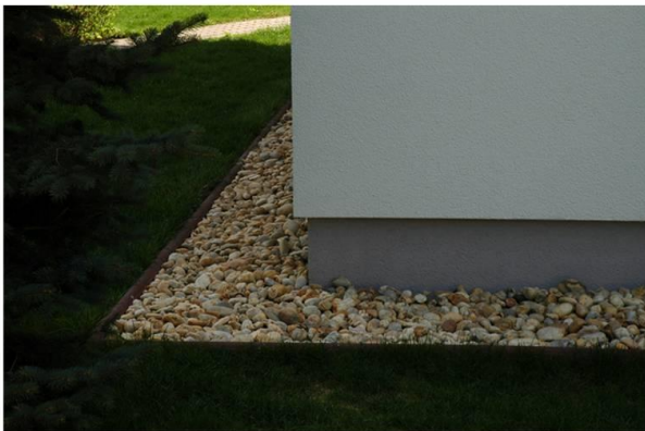
Abbildung 6: Rückspringender Standardsockel als definierter Übergang zwischen Keller und Holzbauwänden. Deutlich erkennbar sind auch die farbliche Trennung sowie das Kiesbett.
